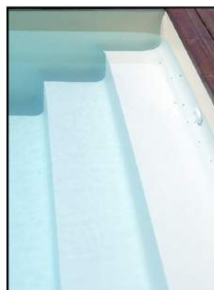
Escalier intérieur entre angles droits
